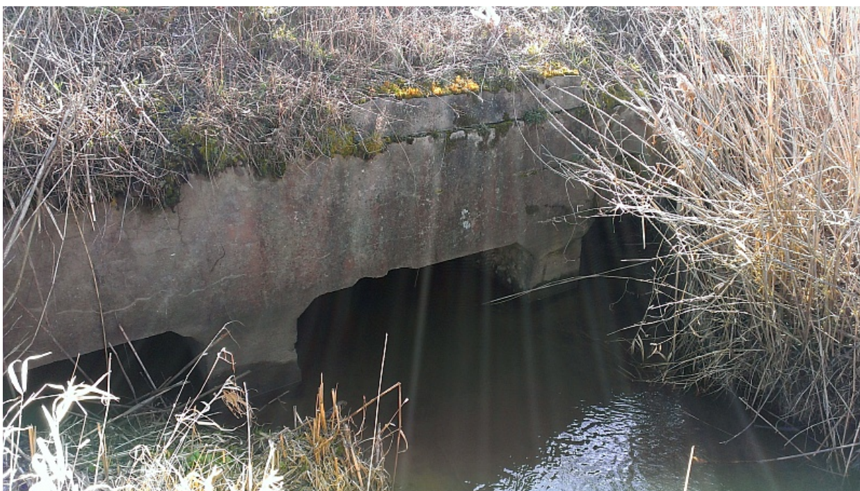
Ilustracja 6: Przepust pod nasypem w rejonie Wawrowic.
